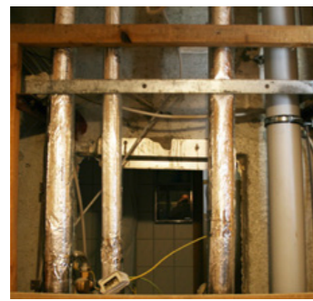
Blick in einen Heizungsschacht
